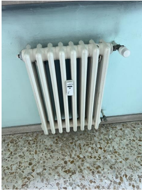
Termosifone con termostato
