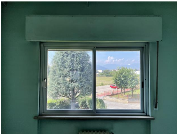
Dettaglio della finestra in alluminio e camera
