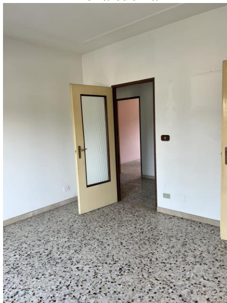
Dettaglio pavimentazione in graniglia e porte originali
