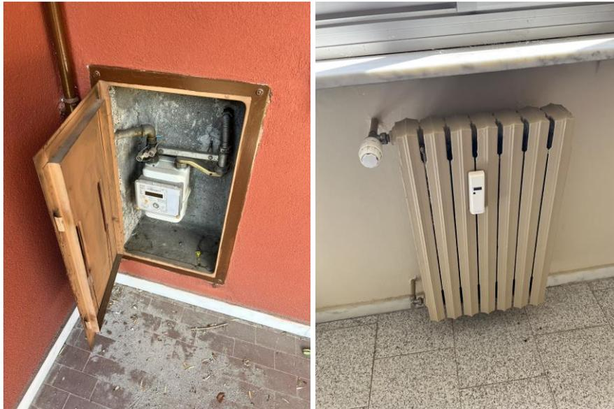
**Figura 9 contatore gas in balcone, termosifoni con termo-valvole**
