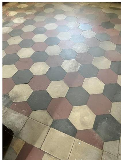
**Figura 11 dettaglio delle pavimentazioni originali, cementine**
