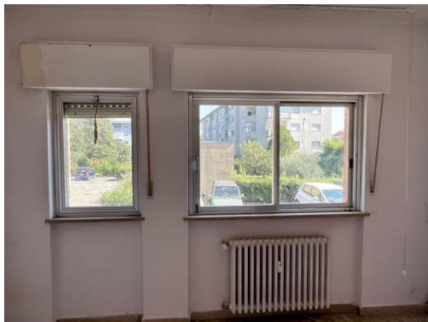
Finestre in alluminio con vetri singoli (camera) e balcone
