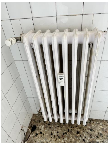
Termosifoni con termovalvole e boiler elettrico
