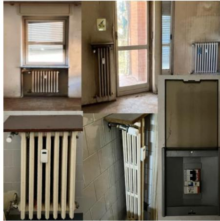
**Figura 10 termosifoni con termovalvole e contatore**
