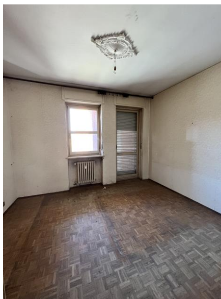
Figura 5 camera con finestra e porta finestra allo stato originale e pavimento parquet (affaccio su parcheggio e area verde)
