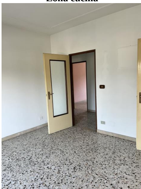
Dettaglio pavimentazione in graniglia e porte originali
