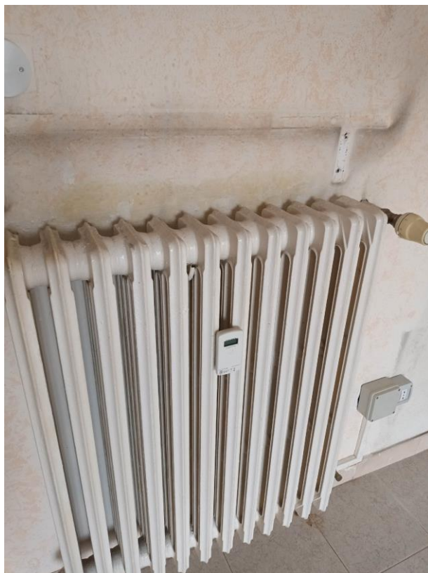
Figura 6 termosifone con termovalvole
