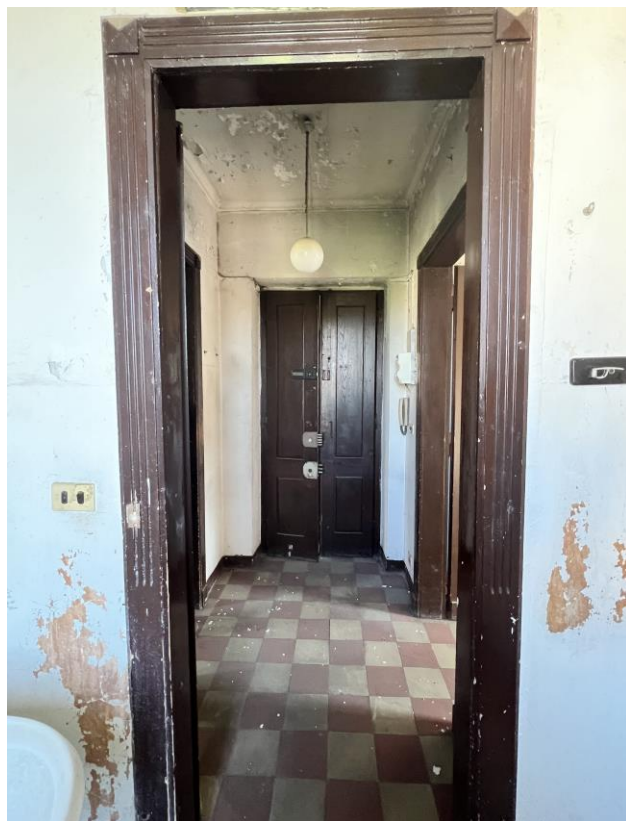
Figura 5 corridoio e porta in legno
