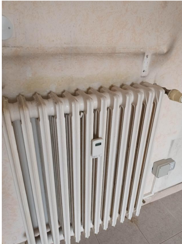
Figura 6 termosifone con termovalvole
